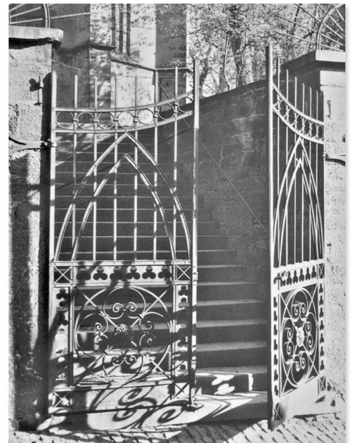
Treppenaufgang mit Pforte zwischen Schloßkirchenweg und Schloßkirchenpark (aus: Timm, Alt-Pforzheim)
