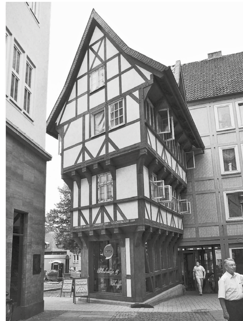
Hildesheim: Rekonstruiertes „Mikrohaus“ im Bereich der kriegszerstörten Altstadt (Foto: C. Timm)
